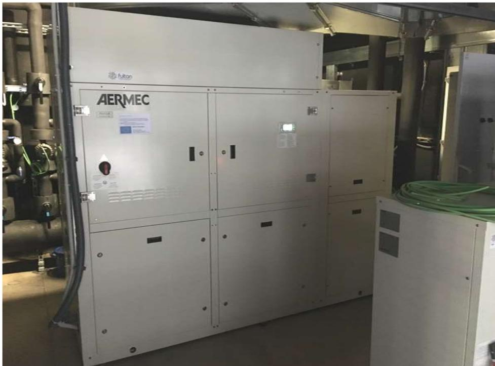
Figura 4a. Sistema de agua refrigerada para sala limpia ISO7/8 - Enfridora de agua con bomba de calor
