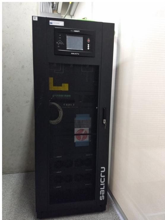
Figura 5. Sistema de alimentación ininterrumpida - SAI Salicru SLC 3/6 ADAPT120
