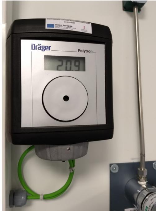
Figura 1. Detector de gases POLYTRON C3000
