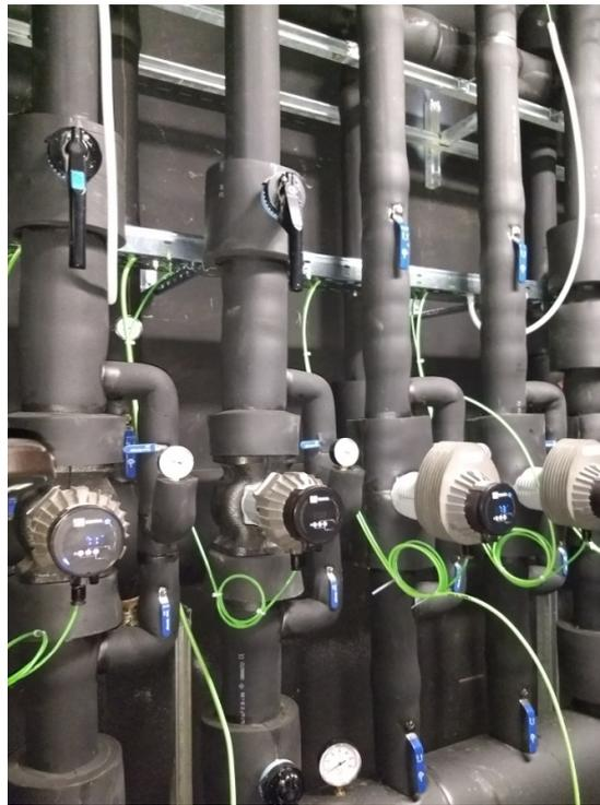
Figura 4b. Sistema de agua refrigerada para sala limpia ISO7/8 - Sistema de transferencia de energía
